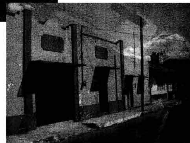
Aplanados en fachadas y cubiertas inclinadas.
