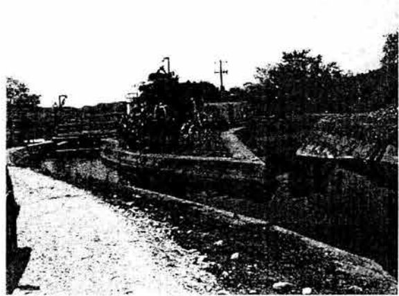
Figura 1.3 - Obra de toma para el abastecimiento del Distrito Industrial Marítimo
