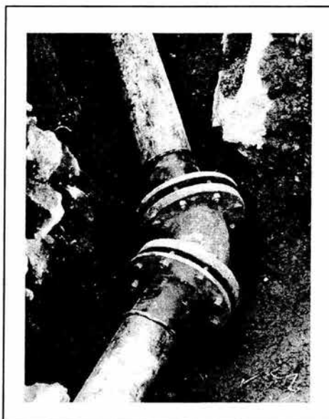
FIGURA V.19 TUBERÍA REPARADA
