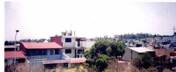
(3) VISTA NOROESTE Casa habitación, calle de las Americas.
