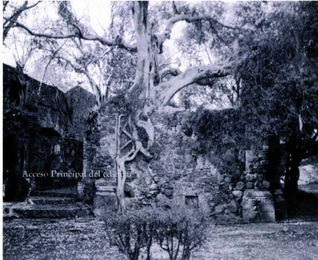
Este es edificio que funciono como hornalla y trapiche, es una vista frontal de esté y será restaurado para ubicar el restaurante principal del conjunto
