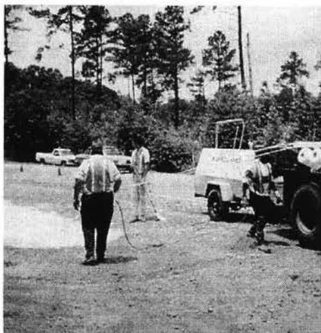
**Figura 29: Extendido del Roving sobre del suelo por revegetar.**
