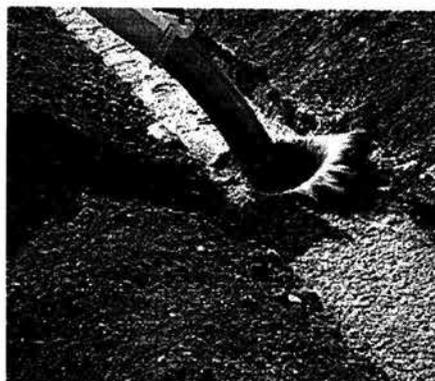
Figura 11: Relleno de zanjas con Concreto Fluido
