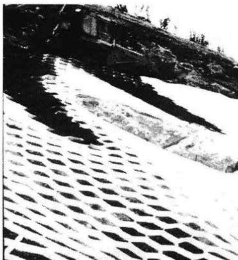
**Figura 32: Confinamiento en Geoceldas en un talud, siendo rellenado con suelo.**
