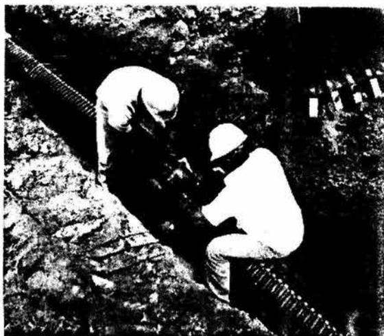
**Figura 9: Colocación de una tubería HDPE**
