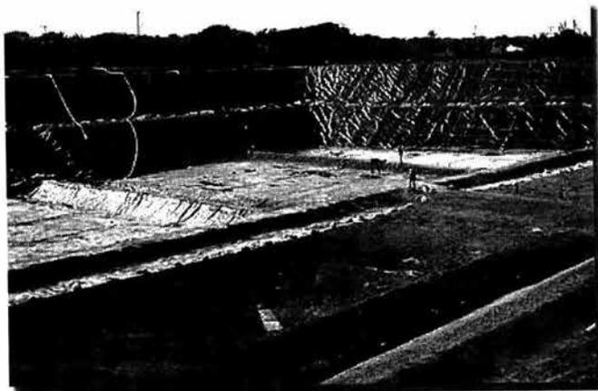
**Figura 45: Sitio dispuesto para relleno sanitario o confinamiento de residuos peligrosos con utilizando geomembranas.**
