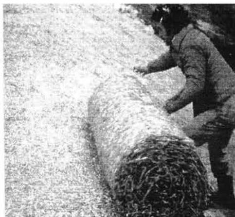
**Figura 30: Instalación en talud**
