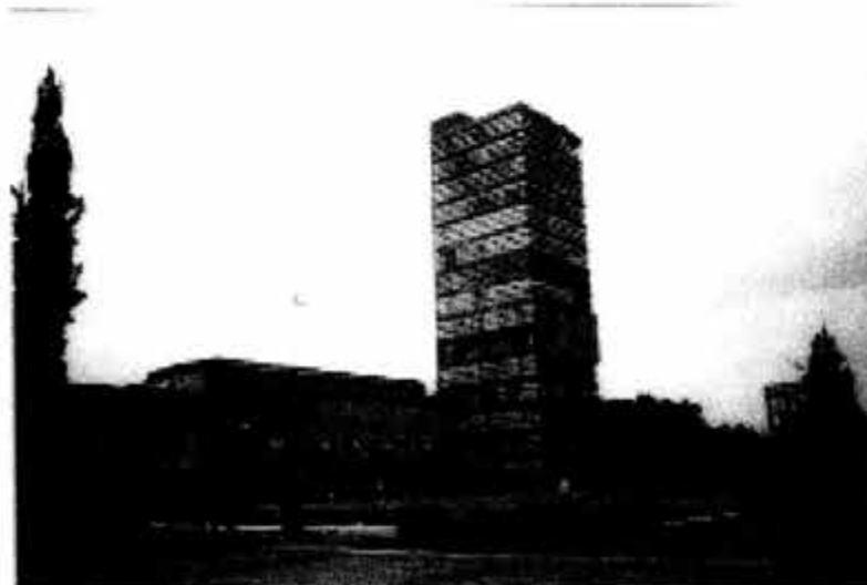
Figura 19-. Fachada sur-oeste de Rectoría, UNAM
