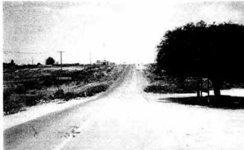
Figura 14-. Electrificación sobre carretera.
