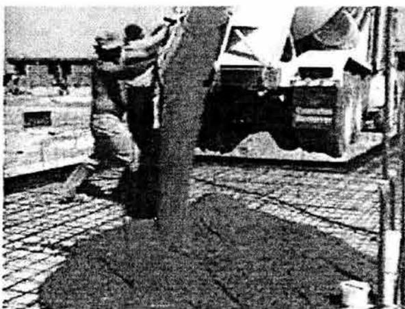
Foto V.2.2 Colado del concreto en losa de cimentación.
