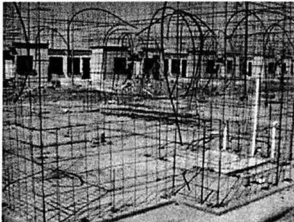
Foto V.3.1 Colocación y armado del acero de refuerzo en muros.
