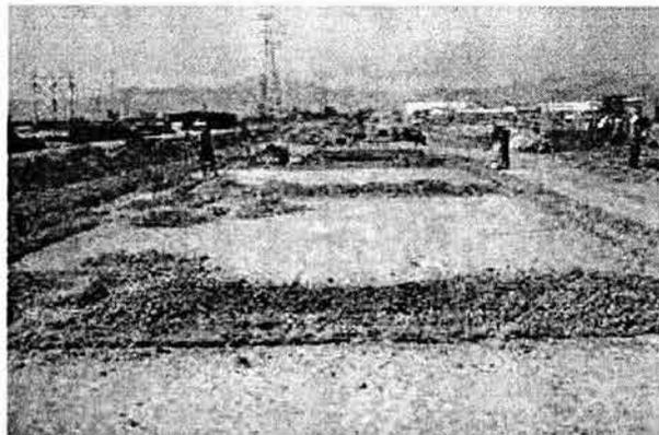
Foto V.1.2. Excavación para zapatas de cimentación.
