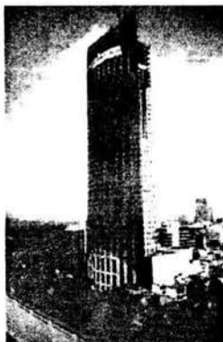
Figura 3.29. Edificio Torre Mayor con amortiguadores viscosos (Tena, 2003)
