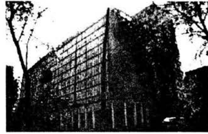
Figura 3.27. Reestructuración de las oficinas centrales del IMSS (Tena, 2003).
