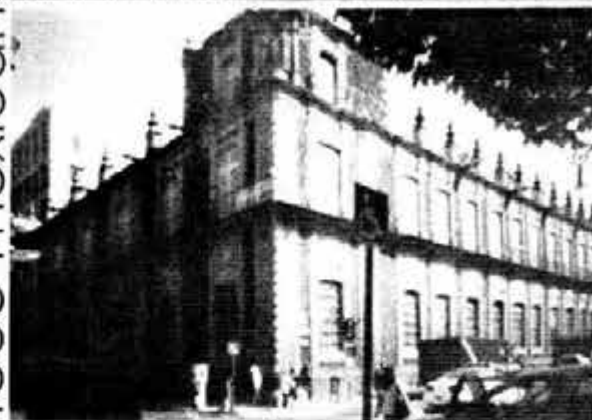
Casa de los Condes de San Mateo Valparaíso, hoy oficinas de Banamex
