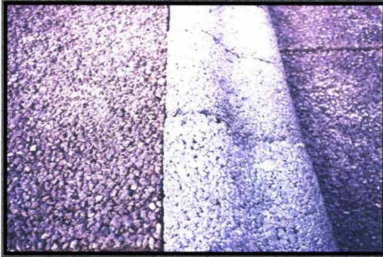
FOTO No. 2.21 BORDILLOS Y GUARNICIONES DE ECOCRETO
