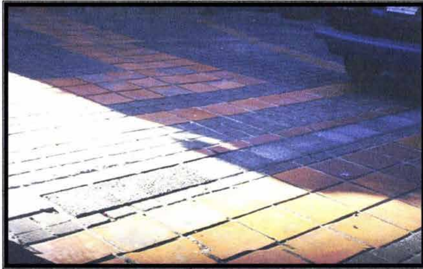
FOTO No. 2.23 USO DE PIEZAS DE ECOCRETO EN LUGAR DE REJILLAS
