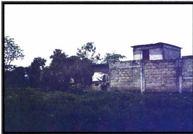
FOTO No. 3.30 CASA DE MATERIAL EN MAL ESTADO
