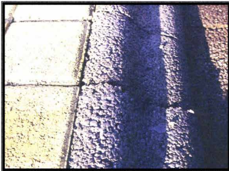
FOTO No. 2.22 BORDILLOS Y GUARNICIONES DE ECOCRETO
