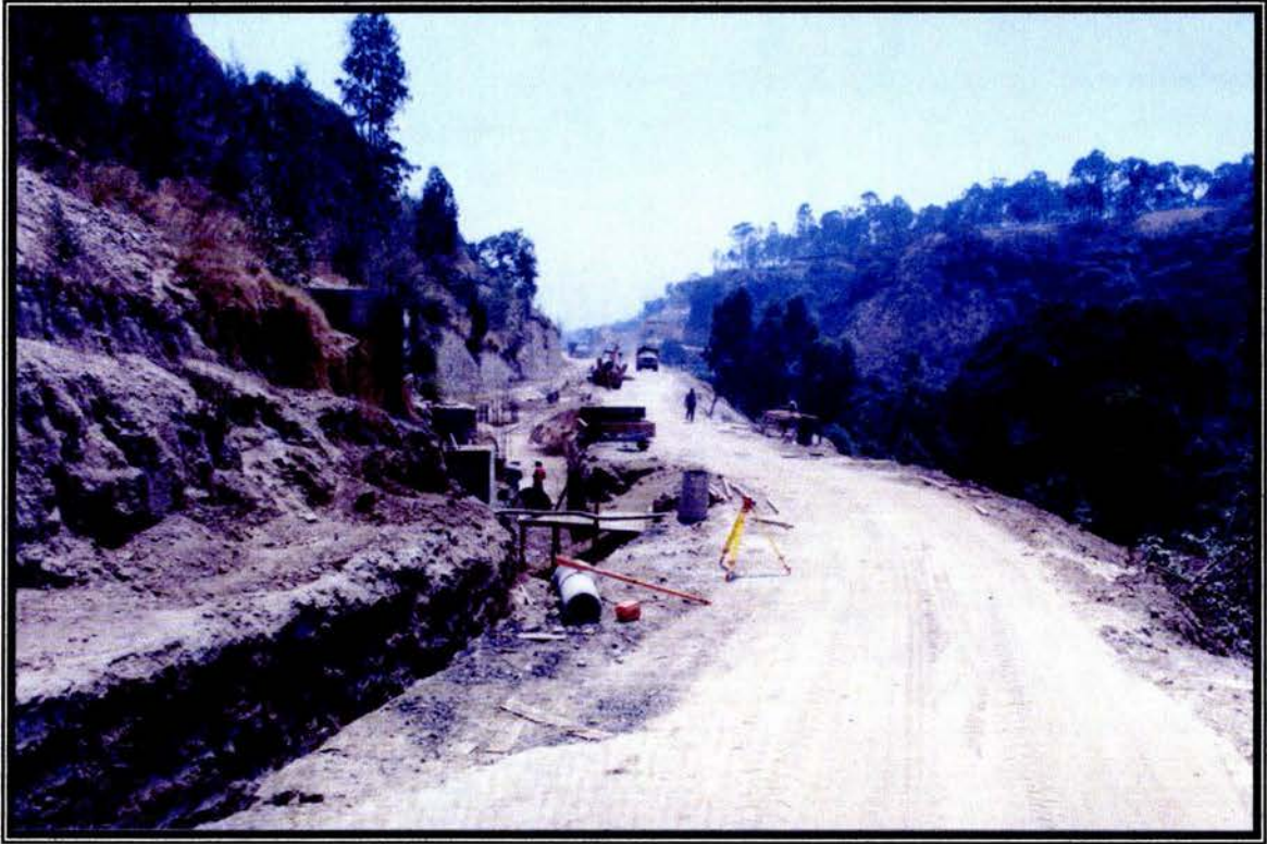
Foto No. 3 INSTALACIÓN DE TUBERÍA DE 107 CM
