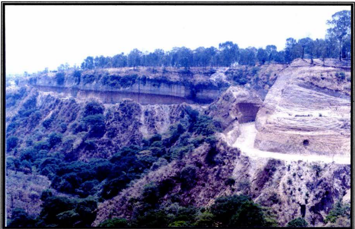
Foto No. 4 CAMINO DE ACCESO, TUBERÍA DE 107 CM INSTALADA
