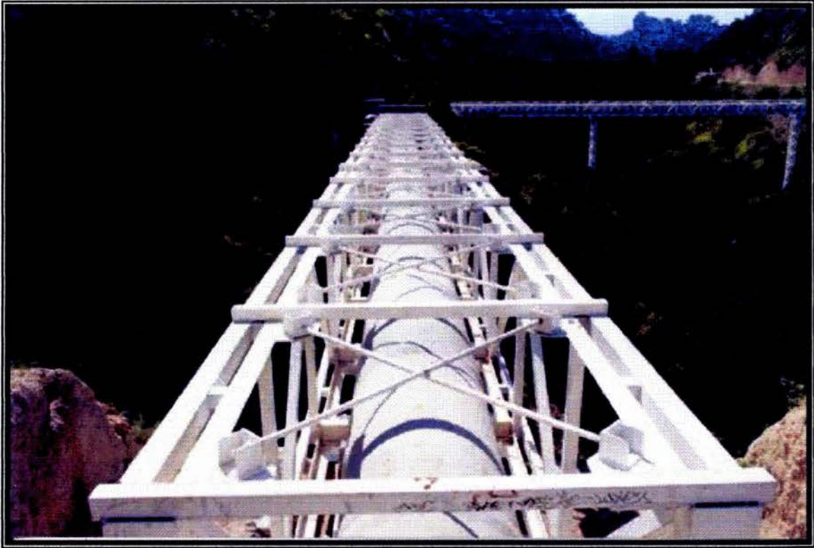
Foto No. 9 VISTA DESDE EL PUENTE No. 2
