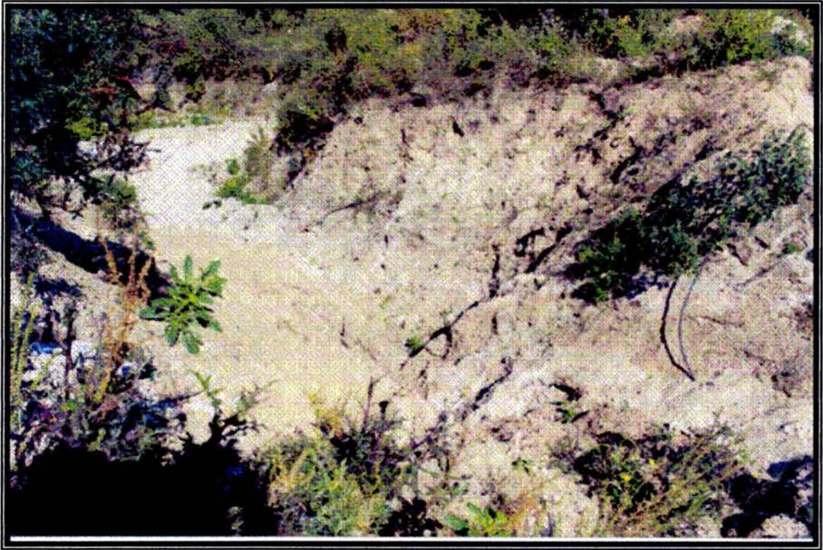
Foto No. 12 DESLIZAMIENTO DE MATERIAL, AL FONDO PUEDE VERSE EL CAMINO DE ACCESO
