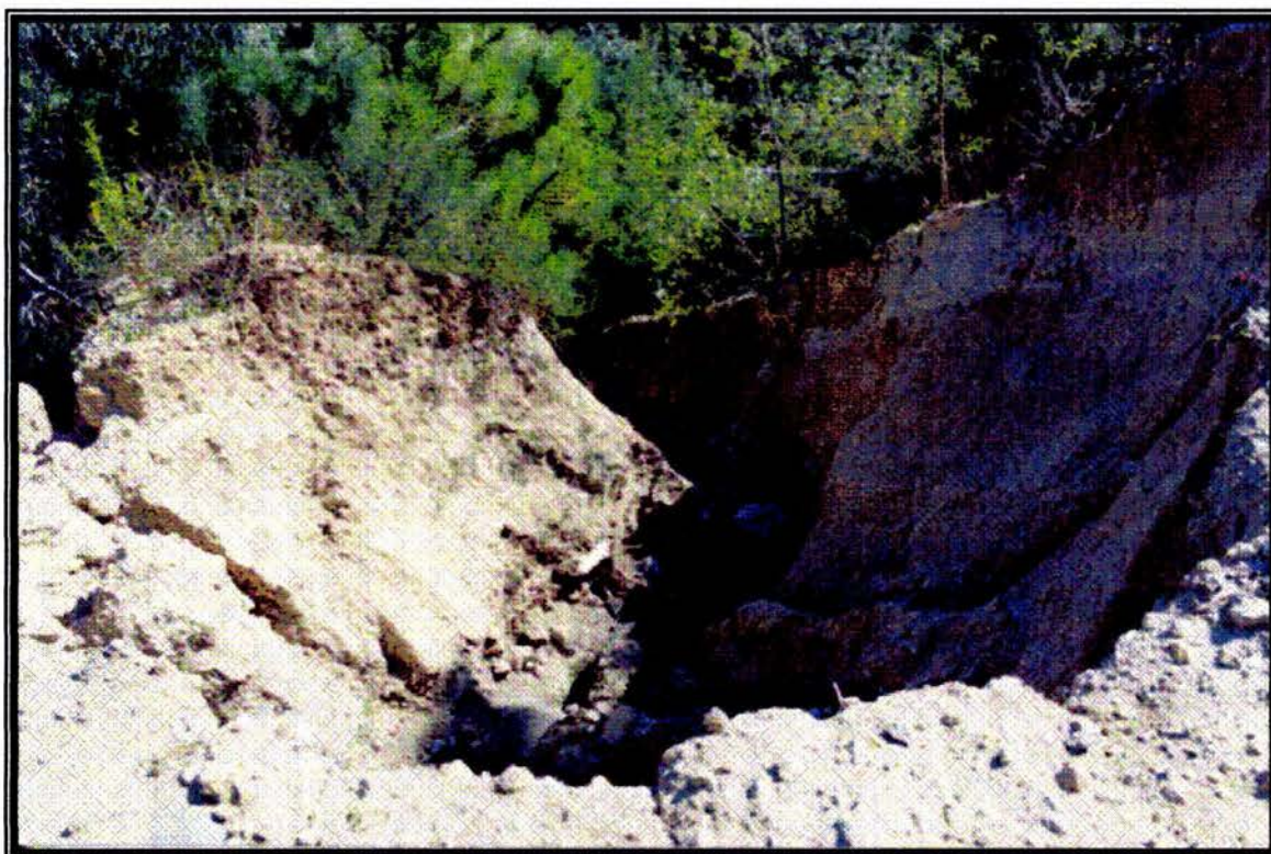
Foto No. 14 OTRA VISTA DE LOS DESLIZAMIENTOS, OCASIONADOS POR LAS LLUVIAS, LOS CUALES PUEDEN PROVOCAR EL COLAPSO DE LA TUBERÍA
