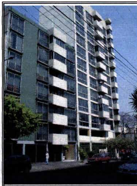
Edificio de Departamentos Avenida Universidad - Zapata
