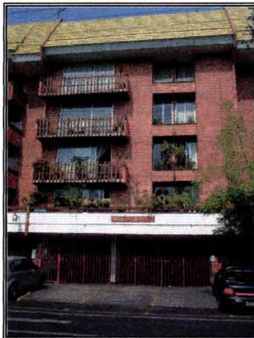
Edificio de Departamentos Avenida Universidad - Zapata
