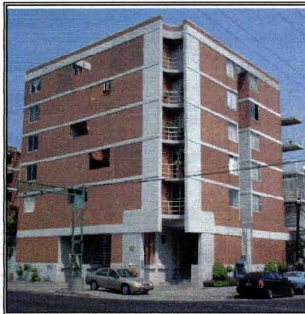
Edificio regular en esquina Eje 4 Sur Xola - Asturias
