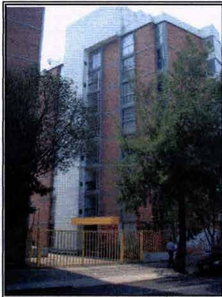
Muro de Concreto Reforzado desplantado desde la Cimentación Avenida Universidad
