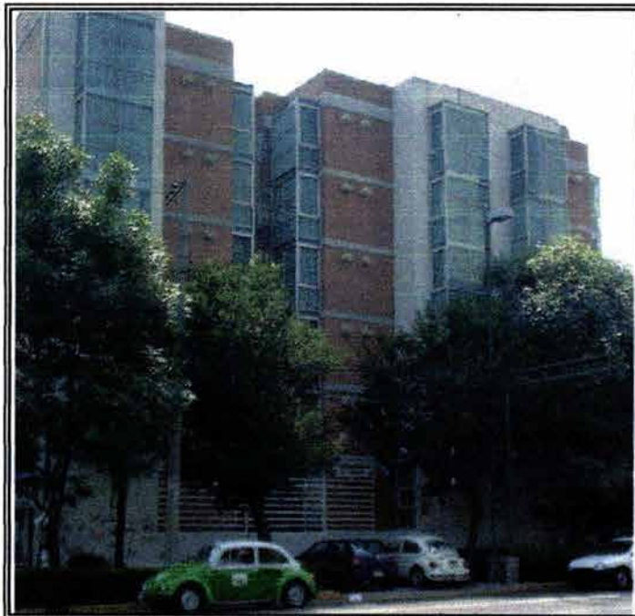
Muros de Concreto Reforzado desplantados desde la cimentación abarcando cuatro niveles Eje Central Lázaro Cárdenas - Eje 4 Sur Xola
