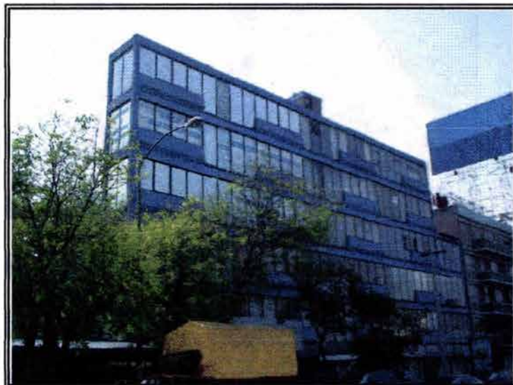
Edificio irregular en esquina (Vista frontal) Avenida Universidad
