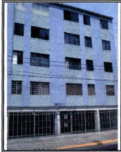
Unidad Habitacional (Fachada Principal) Eje 6 Sur y Avenida Río Churubusco
