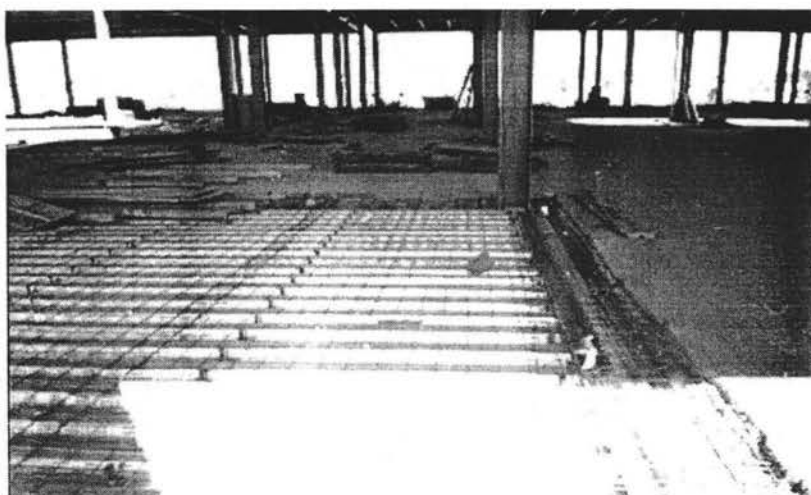
FOTO 25. Montaje losacero etapa 1.
