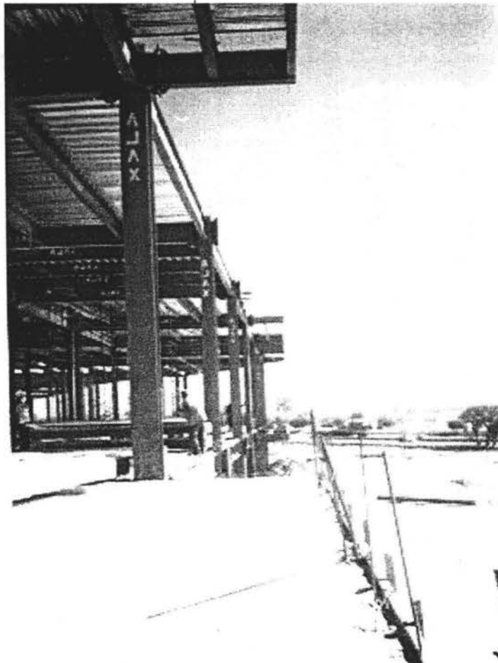
FOTO 17. Elementos de apoyo para lámina losacero.
