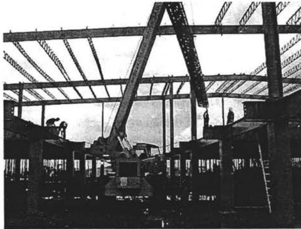
FOTO 23. Montaje de estructura plaza real en Pachuca con grúa
