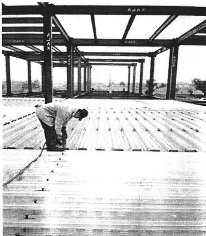
FOTO 19 Y 20. Colocación de lámina losacero y pernos.
