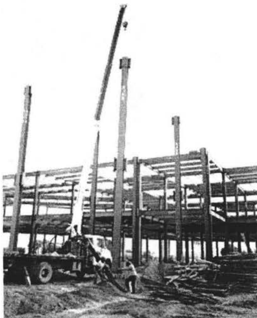
FOTO 25. Montaje losacero etapa 1.
