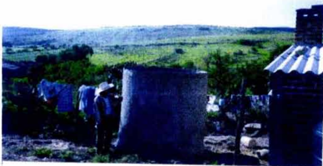
Foto 3. Tanque de depósito.
