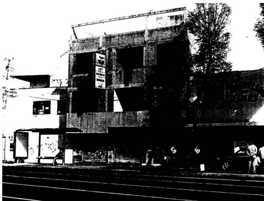
FOTO 3.- Este inmueble se encuentra de igual manera sobre la Av. Patriotismo muy cerca del anterior, en el número 136; como se puede observar está incompleto, deteriorado y abandonado; por el anuncio que porta, y las cortinas metálicas en planta baja existían locales comerciales; este inmueble se considera un buen candidato para la aplicación del proyecto en este predio.
