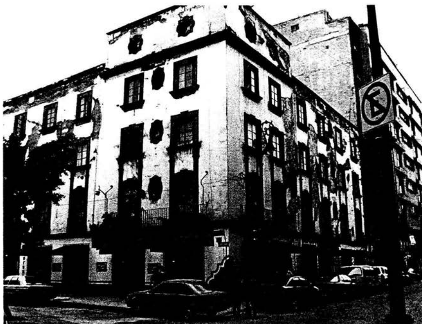
Edificio parcialmente utilizado, como se puede apreciar en la imagen, este inmueble es utilizado únicamente en su planta baja como uso comercial, pero el resto se encuentra sub-utilizado y abandonado; además de encontrarse en malas condiciones estructurales y de seguridad. Donceles esq. Cda. del 57, Col. Centro.
