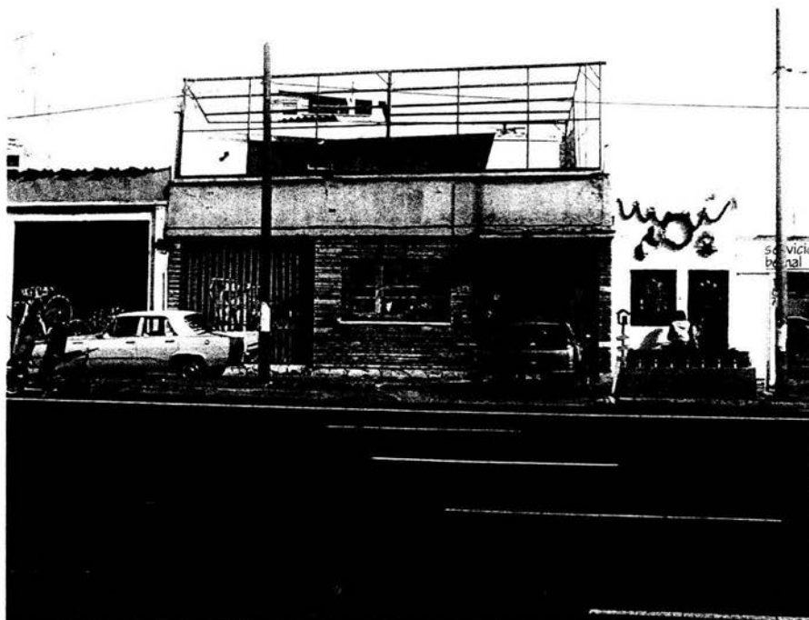
FOTO 2.- Este inmueble se ubica sobre la Av. Patriotismo en el No. 186, como se puede observar está en total desuso, a pesar de tratarse de una construcción aparentemente en buenas condiciones. Para este caso y en función de sus dimensiones y ubicación, sería adecuado revisar su potencial en el programa delegacional.
