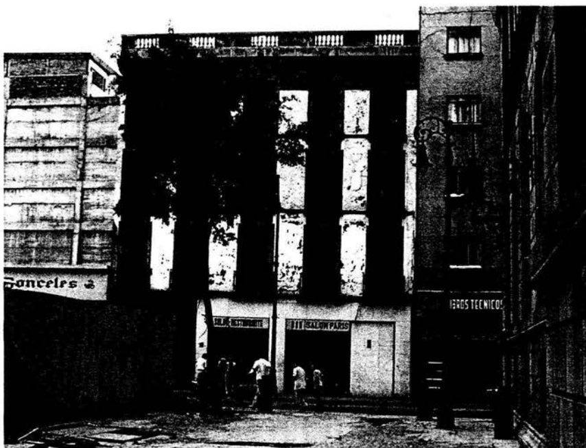
Edificio abandonado y en ruinas, ubicado en la calle de Donceles y casi esquina con Eje Central Lázaro Cárdenas, Col. Centro, Ciudad de México.
