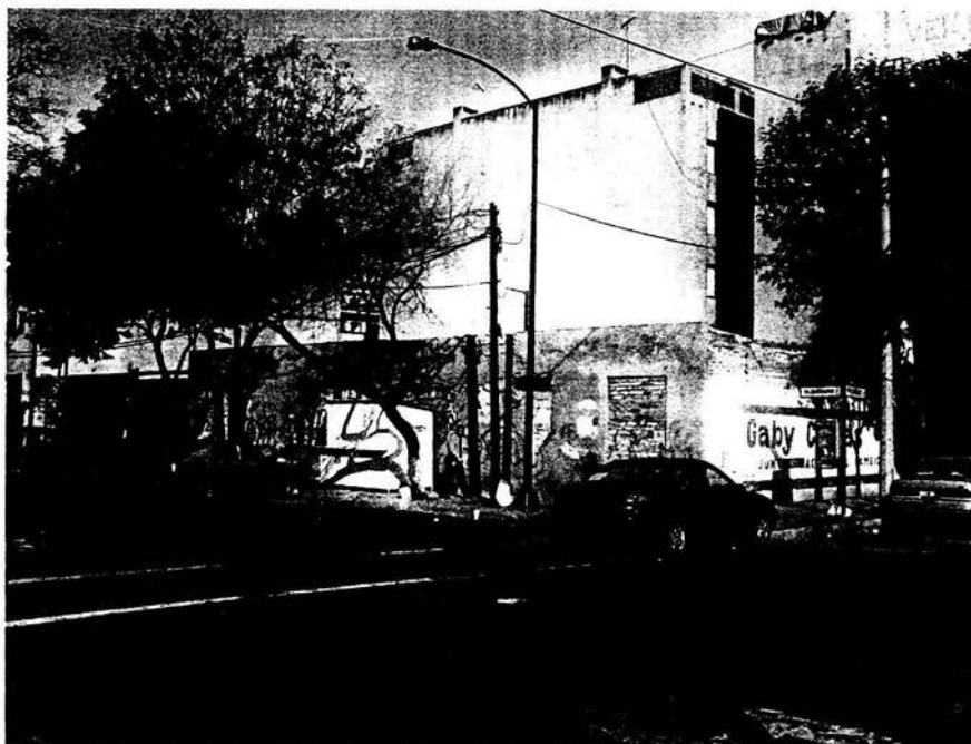
FOTO 6.- Este predio se encuentra ubicado en la esquina de las calles Progreso y Gral. Salvador Alvarado, este predio al parecer no tiene ningun uso actual, y debido a su ubicación y dimensiones parece ser un excelente candidato para la aplicación de un proyecto de vivienda.
