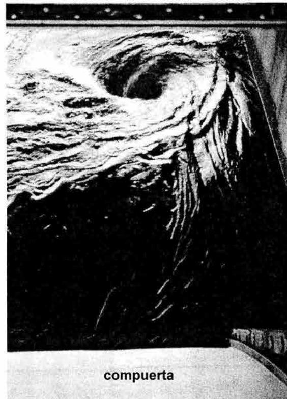
*Figura 2.1.8 Vórtices con embudo de aire, observados aguas arriba de las compuertas de la presa Folsom CA. U.S.A., U. S. B. R. Higgs A. J. (1997).*
