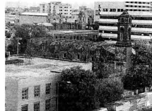
vista desde la azotea del edificio jeanne d'arc
