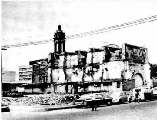
la iglesia, ya aislada, en los 60s: se nota marcada en sus muros la altura del hospital, bien como las ventanas tapiadas.
