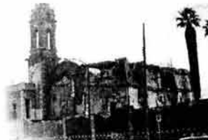
Acceso desde la calle para culto
