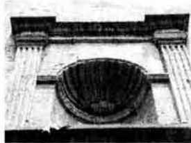
pórtico y grieta travesando el nicho
