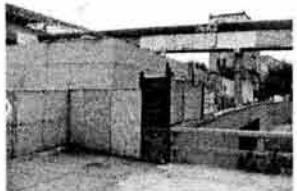
6. Acceso sobre la avenida Fray Servando Teresa de Mier al mercado de Pino Suárez
