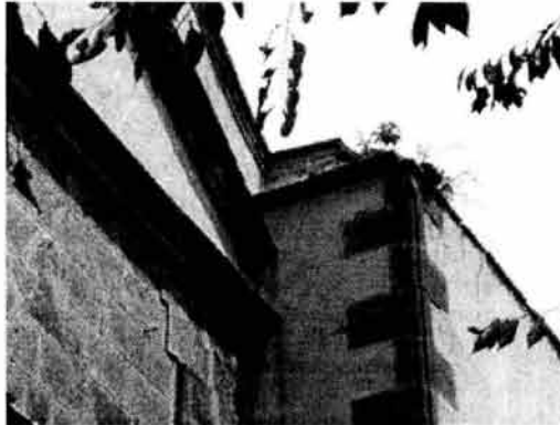
arranque de torre del lado sur
