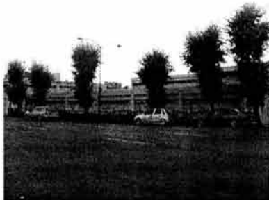
edificio de la dirección general de emergencia y rescate
