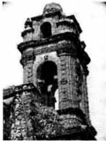
faltantes en la torre y vegetación en la fachada norte
