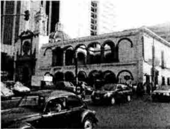
Hospital de Montserrat - "herida expuesta", la cual deja patente al exterior la estructura del edificio; la fachada poniente de San Antonio Abad habrá tenido aspecto semejante de 1955 a 1963.
