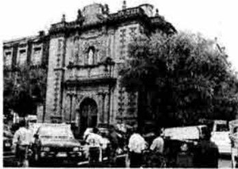
Iglesia de San Bernardo - "herida cicatrizada" por reubicación de pórtico lateral cerrando la nueva fachada.
