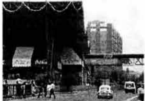
5. Acceso sobre la calzada de San Antonio Abad al mercado de Pino Suárez
