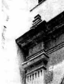
pórtico y grieta travesando el nicho
