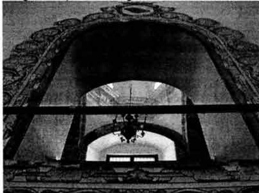
sur: detalle en de la iglesia de Montserrat
