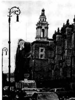
hundimiento diferencial de la iglesia de Santa Teresa, centro histórico
