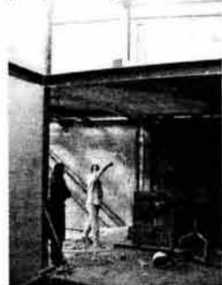
fotografía de obra
