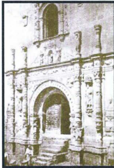
Fachada de la iglesia del convento de Acolman, al recuperar los niveles.
