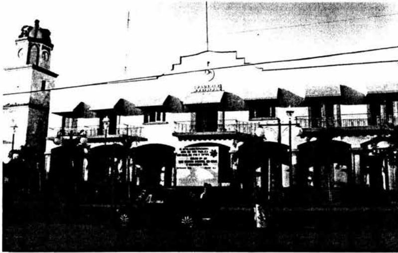
Palacio Municipal, construido en 1952. Salvador Guerrero Moreno es su actual alcalde.
