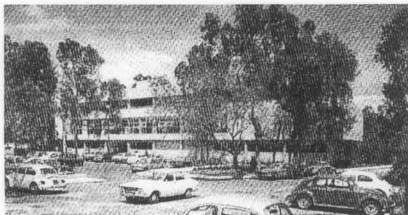
Fotografía4. Vista Exterior del edificio "A" la Tercera ubicación de la biblioteca de la DEPMI.
