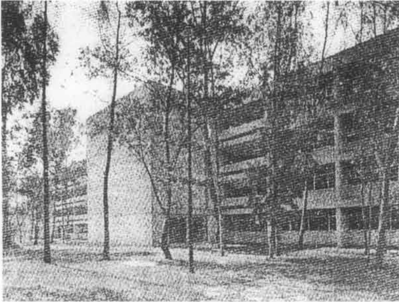
Fotografía2. Vista Exterior del edificio “B” la segunda ubicación de la biblioteca de la DEPFI.
