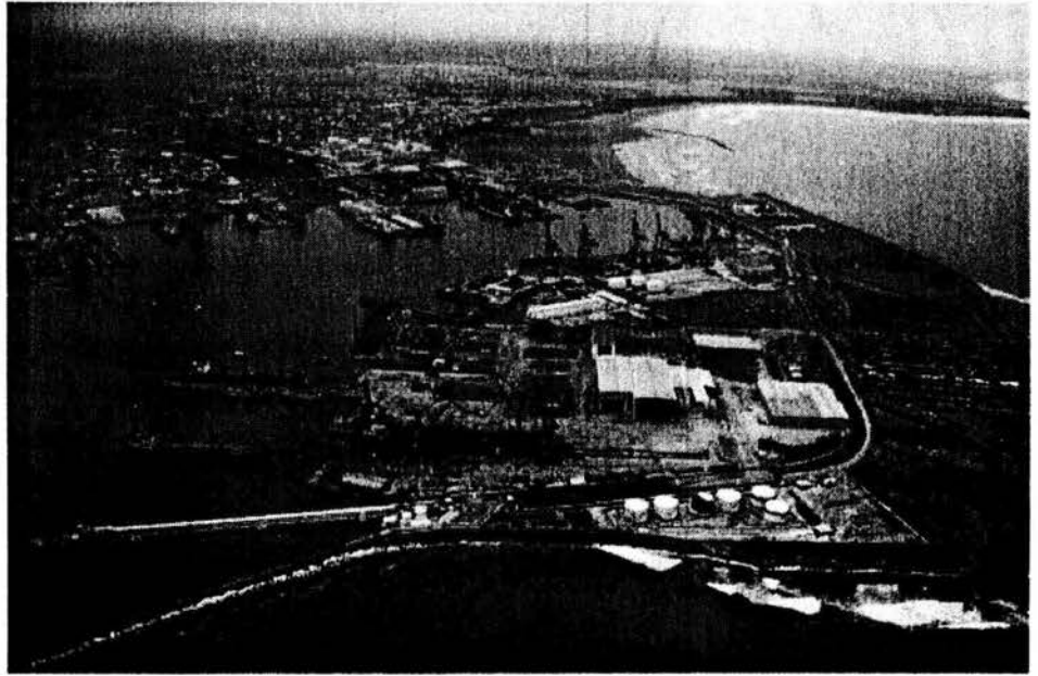
Fig. 23 Vista aerea del contexto urbano
