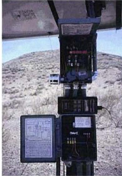
(FIG. 6.22) Controlador típico de un sistema fotovoltaico de bombeo (San Lorencito, Chihuahua)
