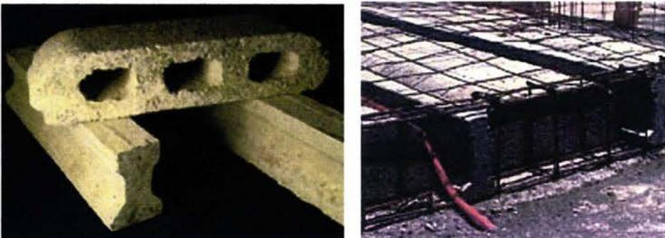
(FIG.6.10) Vigueta y Bovedilla
