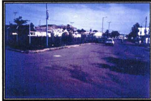
Foto No. 5: Vista del terreno seleccionado, desde la calle Felipe Cortina, viendo hacia el sur.
