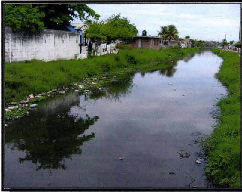
Foto No. 4: Vista parcial del canal La Zamorana que se ubica en la Colonia Carranza.
