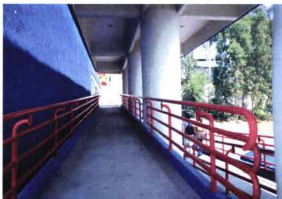
la fotografía muestra rampas exteriores, detalle de barandales
