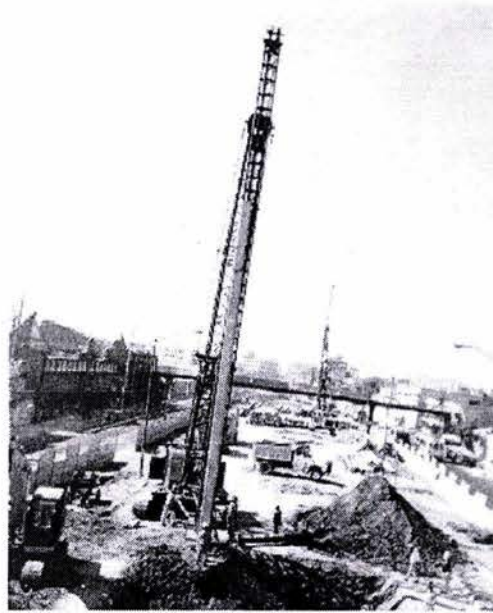
Fig. 5.7 Colocación de un pilote prefabricado (Flores, 2001)
