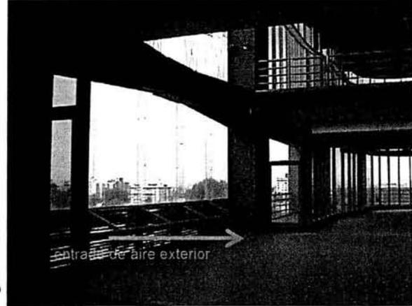
A nivel de piso del nivel oficinas 1, se localiza la compuerta de entrada con una superficie de  $8m^2$  que preferentemente será abierta durante la noche a fin de ventilar el edificio cuando inicia el desprendimiento de energía por la estructura, además de encargarse del "empuje" del aire caliente-viciado generado durante la ocupación de las oficinas hacia un atrio que trabaja como tiro natural de aire caliente o chimenea térmica a lo largo de la torre.
