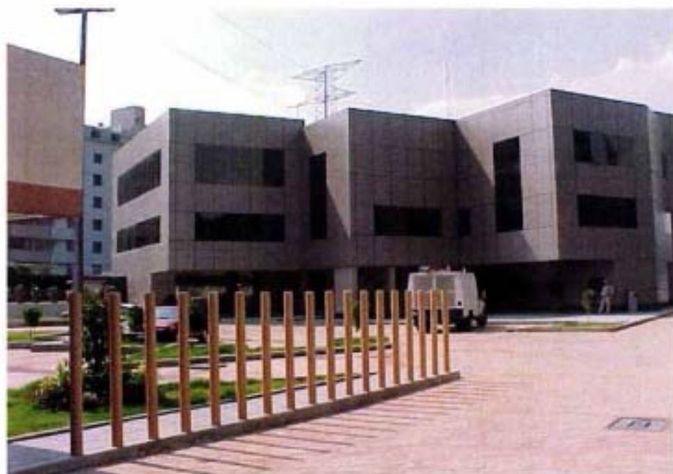
1 a).- Centro Operación Redes de Distribución Pedregal ( C.O.R.D.P. )
