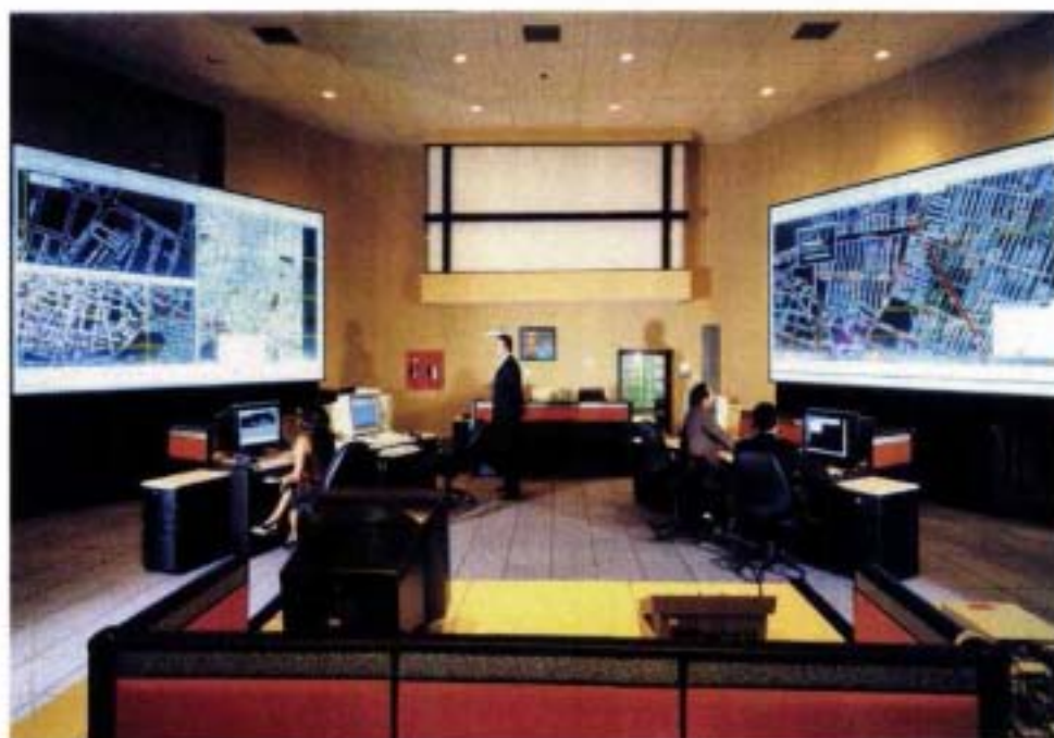
1 m).- Creación del primer Centro de Operación Redes para integrar un Sistema de Administración de Distribución.
