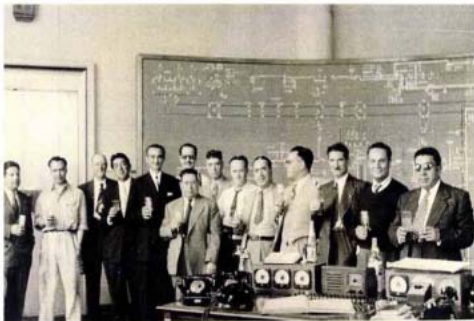
1 d).- La operación de la red es local y se realiza desde las subestaciones existentes.
