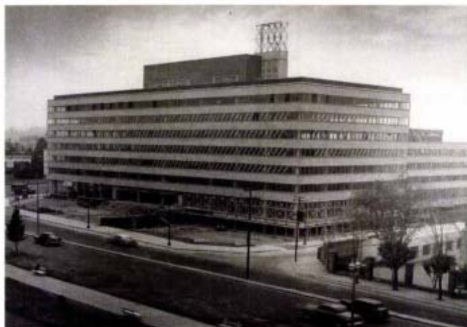
1 h).- Construcción del edificio Verónica
