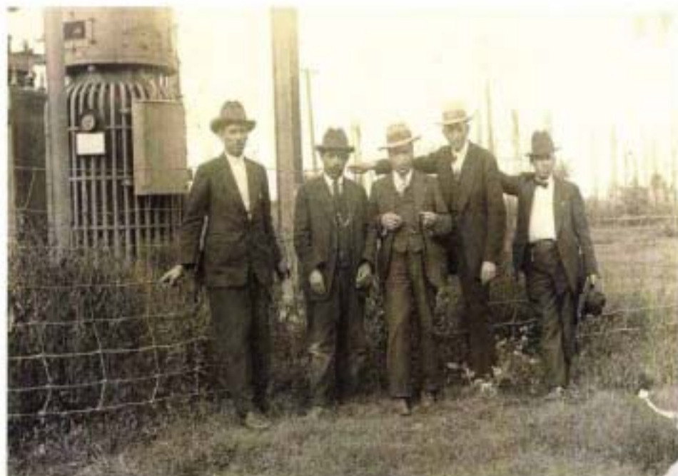
1 c).- Subestaciones tipo Kiosco
