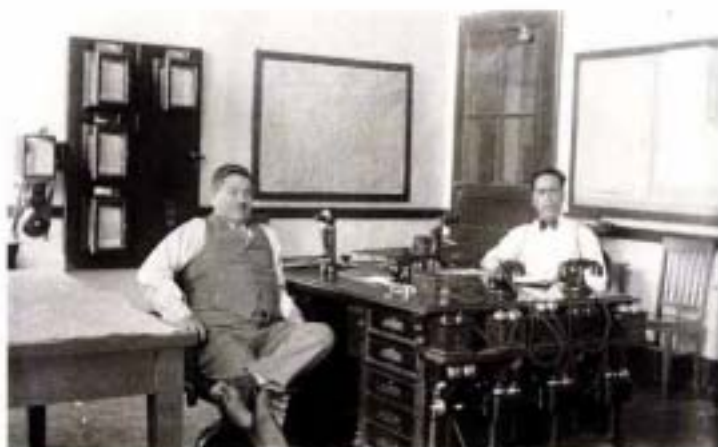
1 f).- Inicio de la operación de la red desde la planta de Nonoálco
