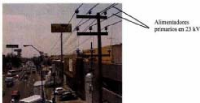
Fig. 2 f) Alimentadores primarios en 23kV.
