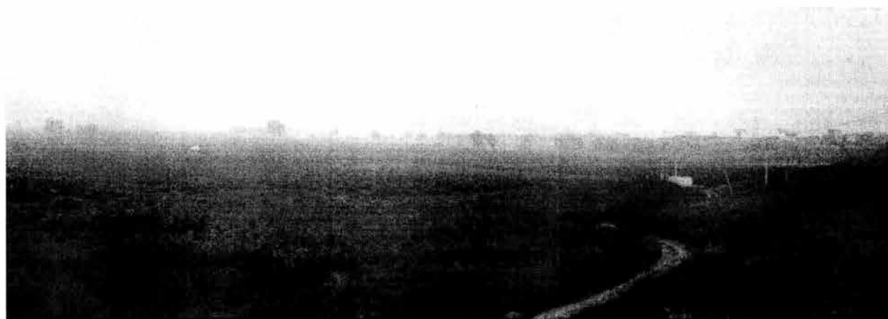
Vista 2. Panorama general del terreno correspondiente al Centro Comercial, se puede apreciar el trazo del camino sinuoso que conducirá a los automóviles alrededor del conjunto.
