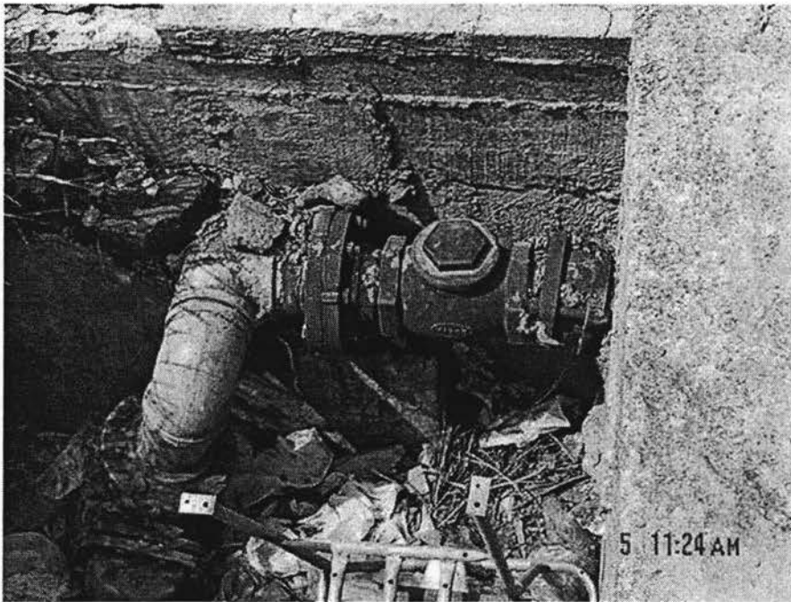
Figura 5 – 14 Vista aérea del sistema de distribución que se encuentra en la parte trasera del gimnasio
