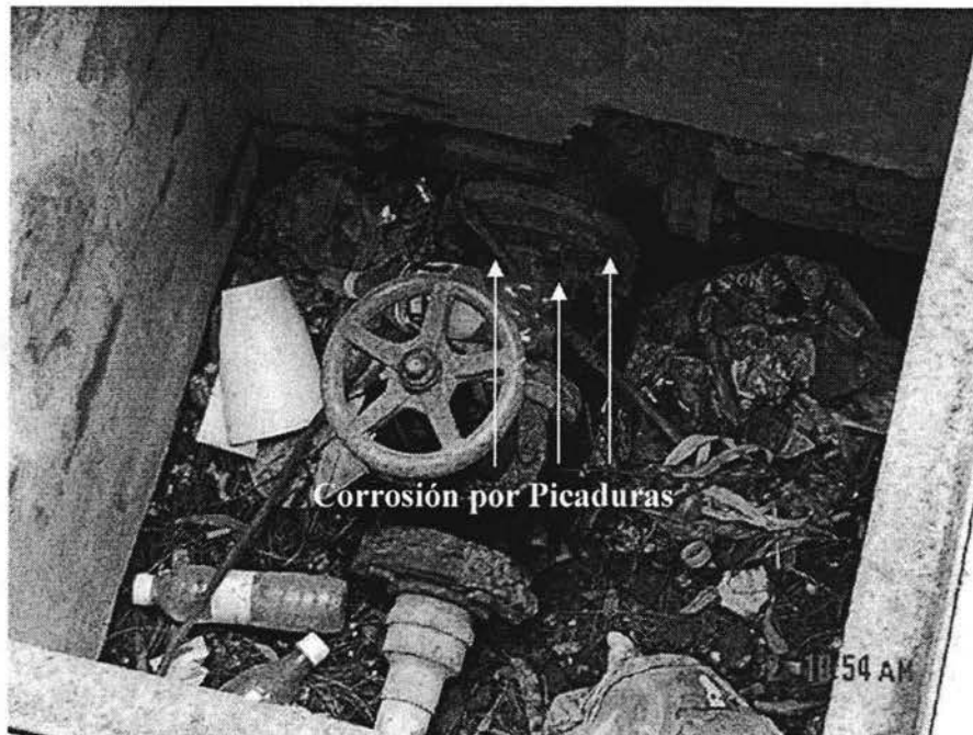
Figura 5 – 7 Vista aérea del registro que se encuentra a un costado del laboratorio L-4
