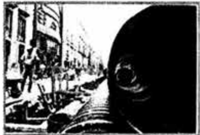
Obras de drenajes
