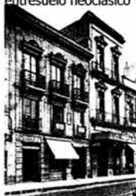
Edificio neoclásico (calle de Guatemala)
