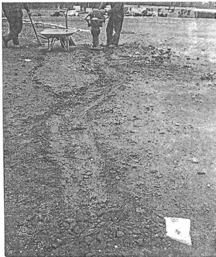
Reparación de grietas en el relleno sanitario Prados de la Montaña
