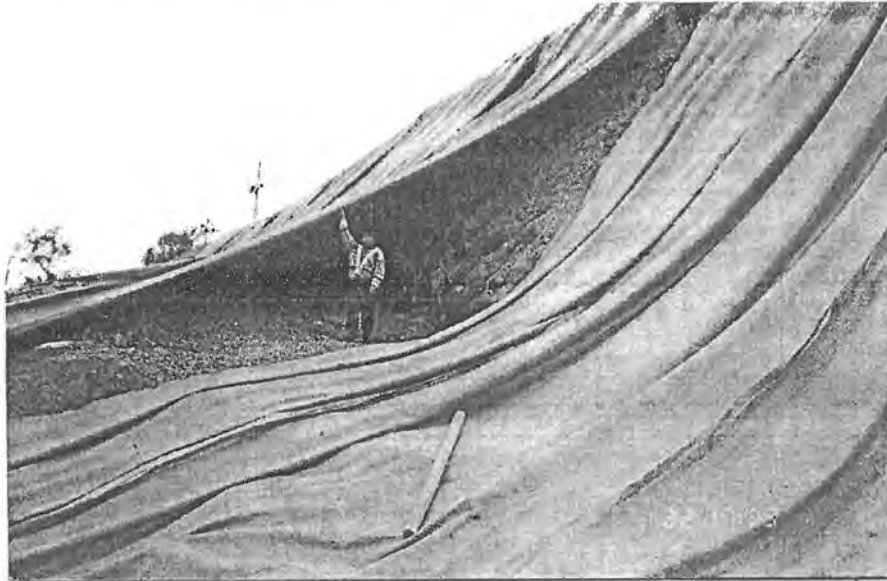
Colocación de geomembrana en el Relleno Sanitario Prados de la Montaña
