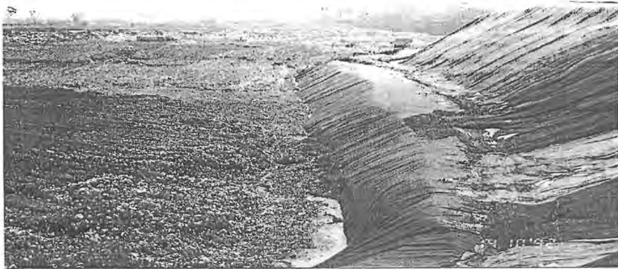
Colocación de geomembrana en el relleno sanitario Prados de la Montaña
