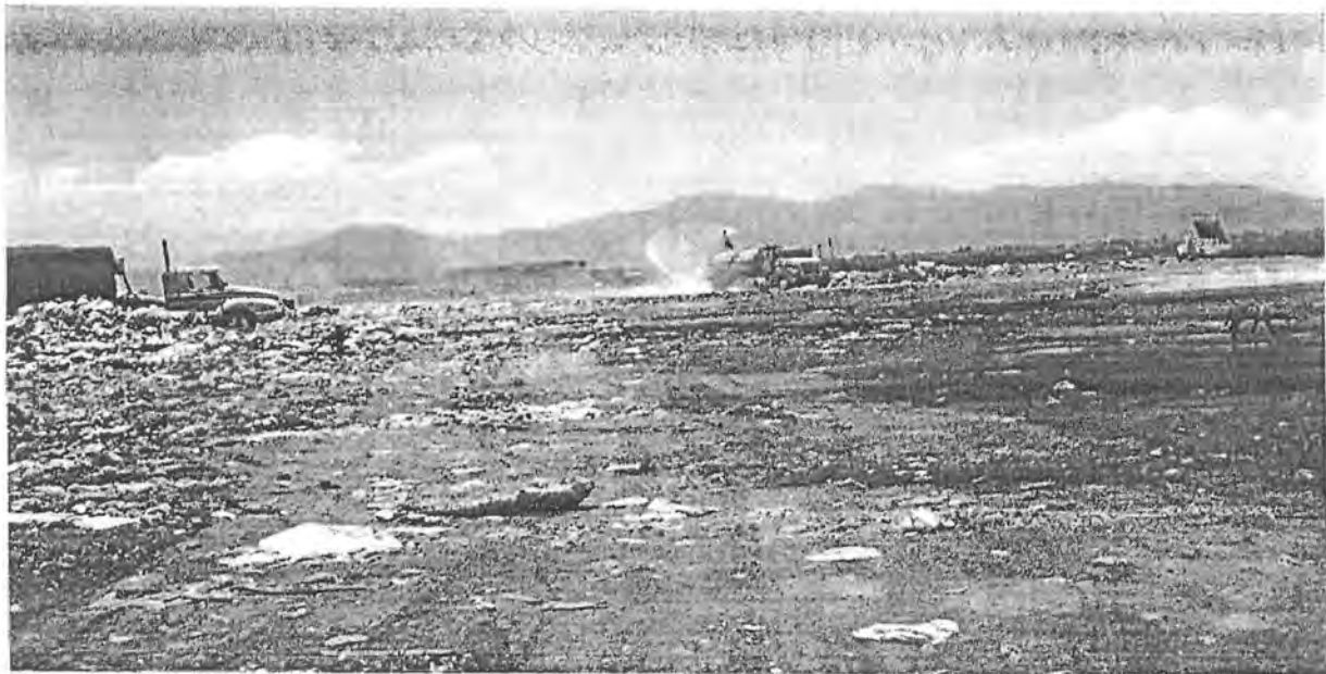
Riego de agua con pipas, del suelo compactado sobre los residuos sólidos, en el relleno sanitario Prados de la Montaña
