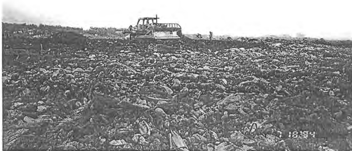
Uso de tractores para el acarreo de los residuos sólidos en el relleno sanitario Prados de la Montaña
