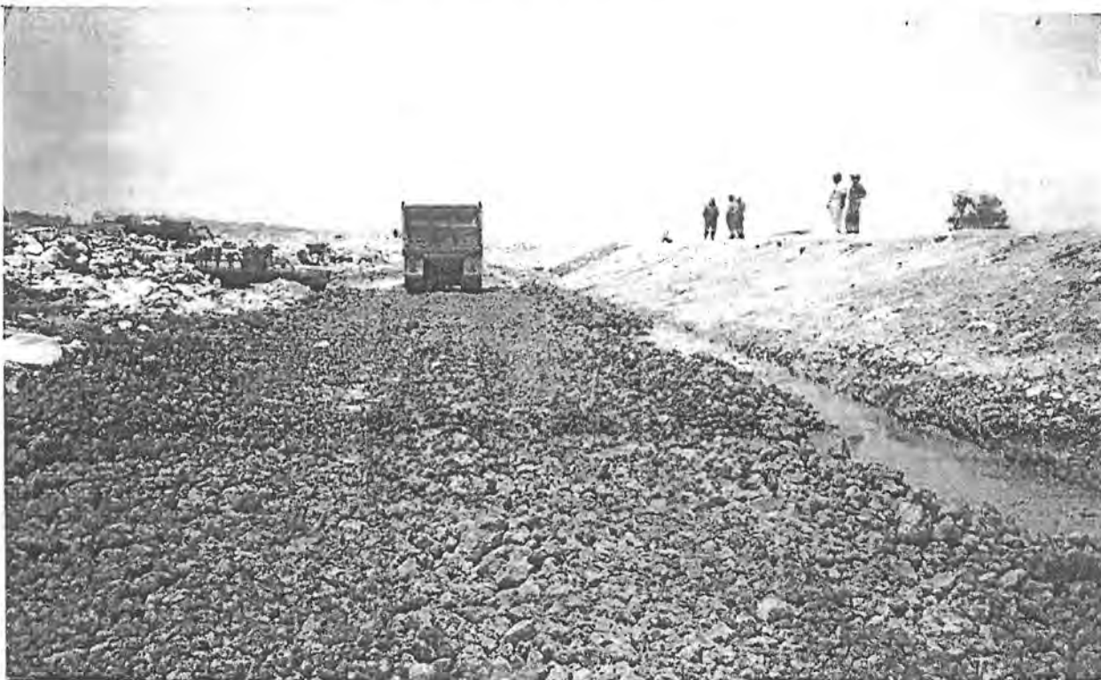
Colocación de capa de sello en el relleno sanitario Prados de la Montaña
