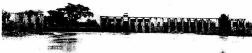
Fotografía 1 Presa Poncitlán con 22 compuertas, agosto 1925.
