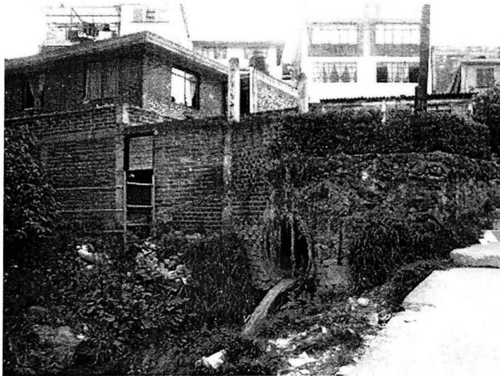
Descarga de drenaje colectivo en la colonia la Malinche en el Andador Durazno, flujo al aire libre.
