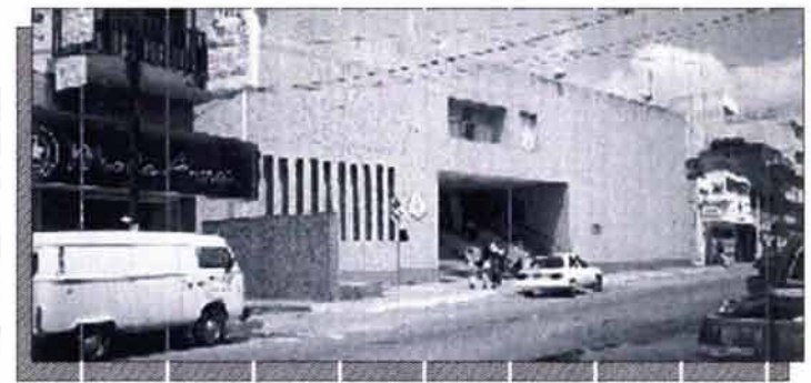
1 FACHADA PRINCIPAL DEL PALACIO MUNICIPAL EXISTENTE EN LA AVENIDA HIDALGO; EN LA COLONIA CENTRO
