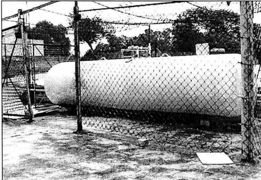
**Foto 8. Tanque de almacenamiento de gas L.P. de la planta fundidora de aluminio.**
