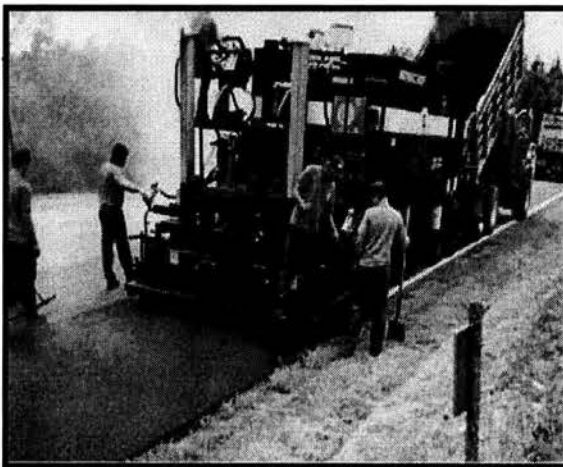
Tendido de carpeta asfáltica
