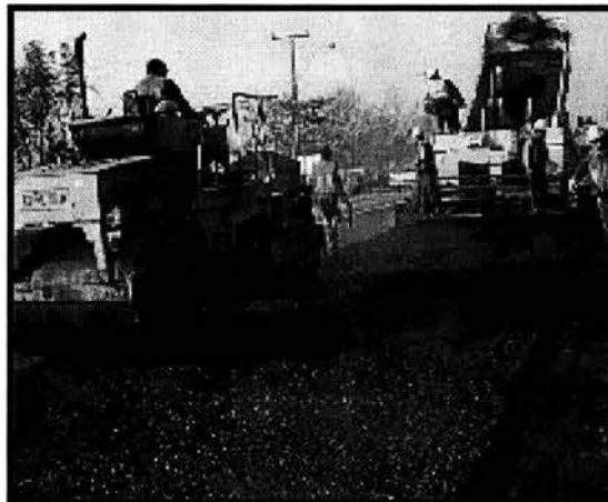
Compactación de carpeta asfáltica
