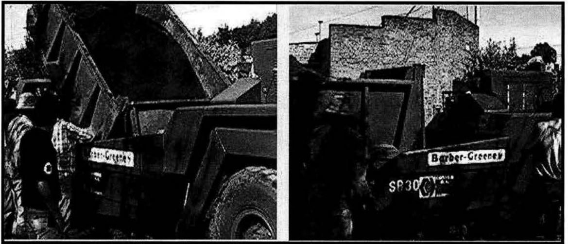
Tendido de carpeta asfáltica
