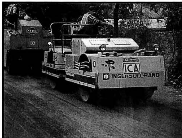
Compactación de carpeta asfáltica
