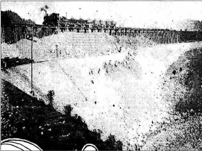
Trabajos ya avanzados en la construcción de la Presa de Tenango. Un tren de carga conduce el material para la construcción. 62
