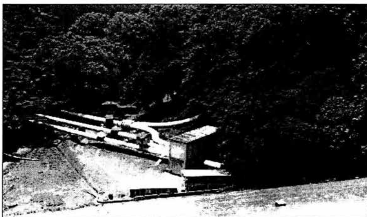
Tubos que salen de la Presa de Necaxa y tubo proveniente de la Presa de Tenango, que van hacia la Casa de Válvulas y Casa de Fuerza (año 2003). 79
