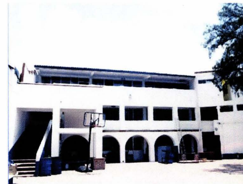
30.- PANORÁMICA EDIFICIO DE PRIMARIA
