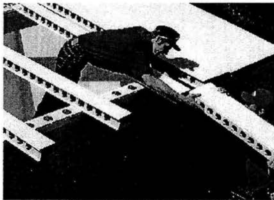
a) Techo de PVC
