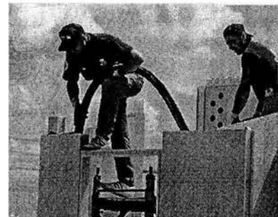
c) colado de los muros
