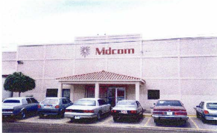
Figura 1.1 Fachada de la planta. (Cortesía de Midcom Inc.)
