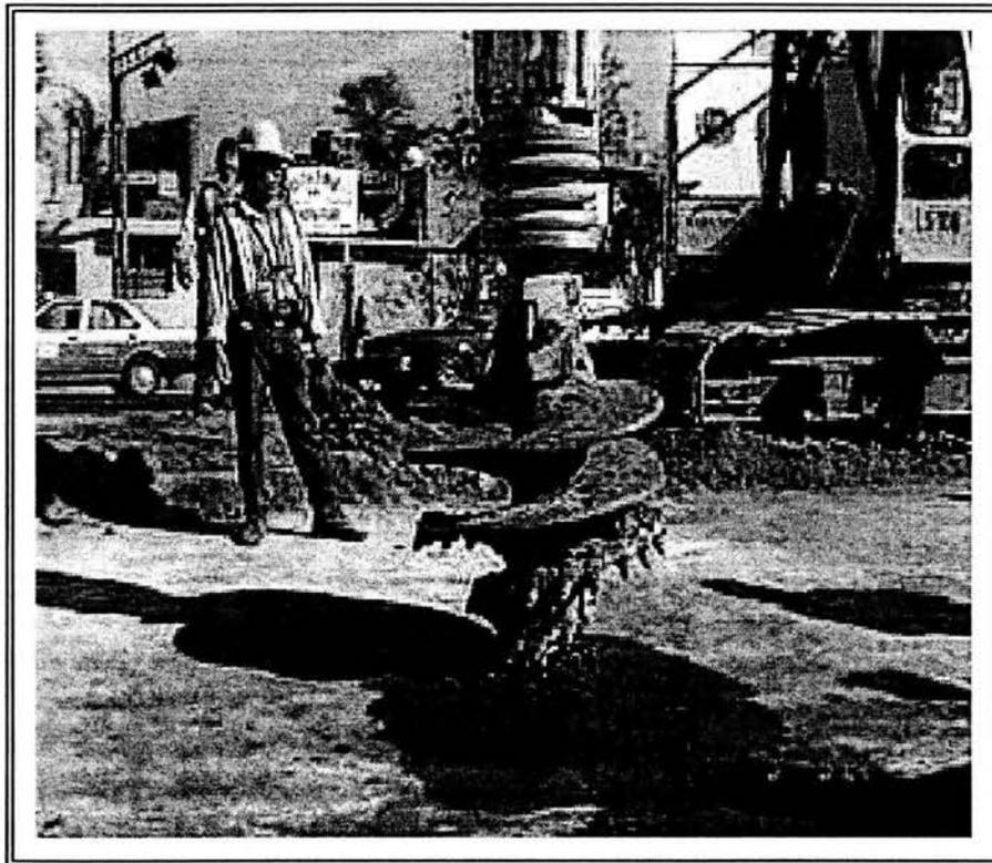
Fig. 5.1 BARRENACIÓN DE TERRENO PARA COLADO DE PILAS.
