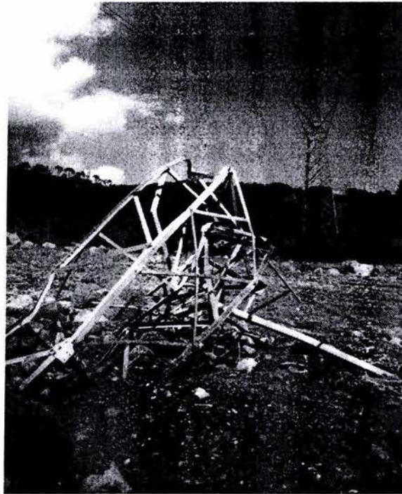
Figura 12. Torre de línea de conducción eléctrica destruída por un lahar en el año 2000 en la barranca Montegrande, a 7.8 km del cráter del Volcán de Colima.
