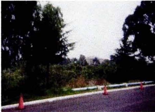
Esta foto muestra la forma en que pasa la red hidráulica, esta es superficial y sujeta por poyos de concreto, localizada por el lado oriente del terreno.
