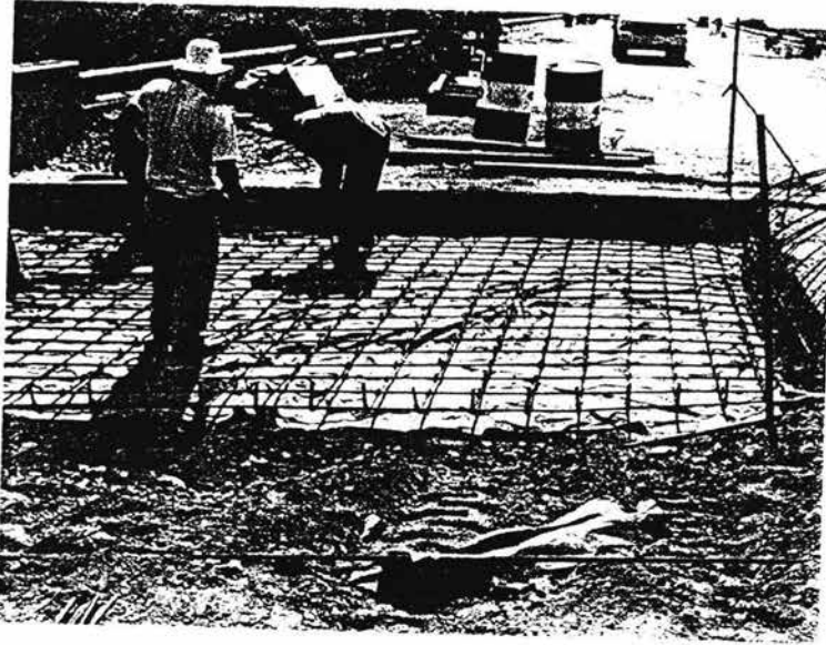
LOSA DE ACCESO ( LADO DE PUEBLA APOYO 4).
