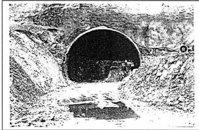
Figura 3.7.3.25 Excavación de la destroza
