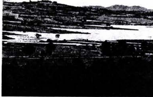
Figuras 1.14 Panorámica de la presa
