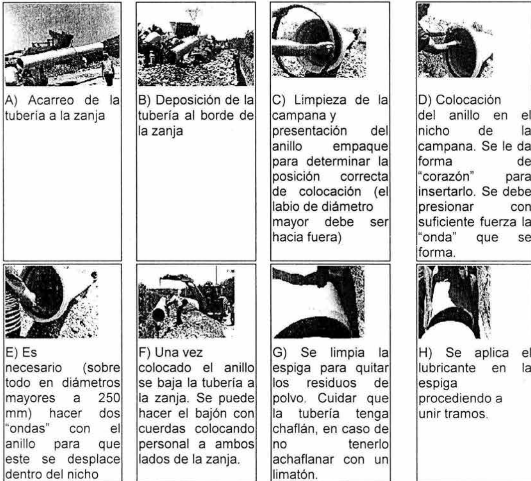
Fig. 7.11 Instalación y acoplamiento de la tubería
