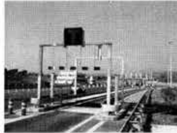
Carril para salir de la autopista, antes de la plaza de cobro.
