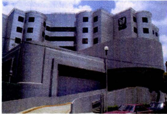
Foto 6. VISTA DE RAMPA DE ACCESO A URGENCIAS
